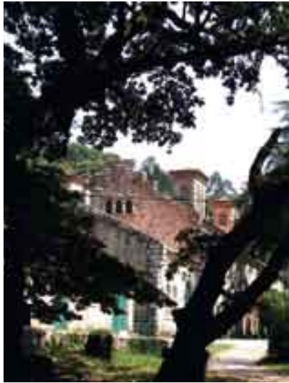
Central hidroeléctrica do Tambre.
